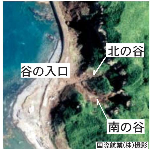
図 5.9: 谷周辺の航空写真（国際航業撮影）
